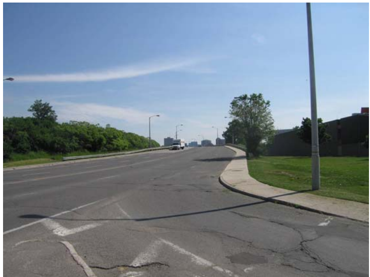
Vue vers l’est, le long du pont de la rue Scott, depuis l’intersection de Scott et Bayview.
