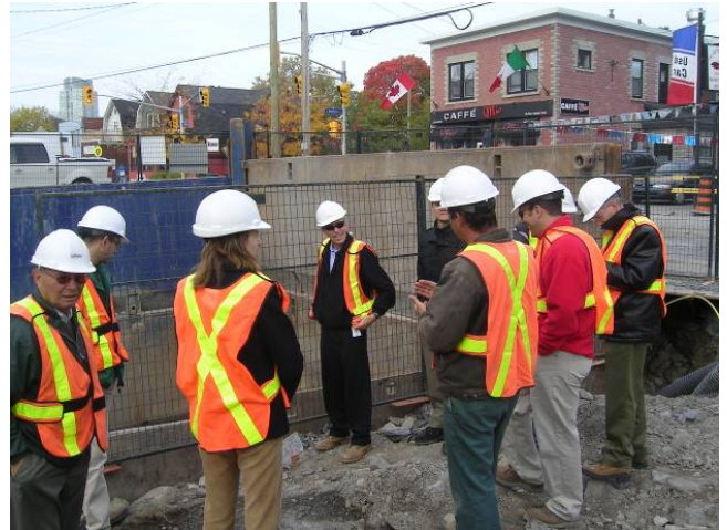
Installation d'égouts Vortex, rue Wellington-Ouest.
