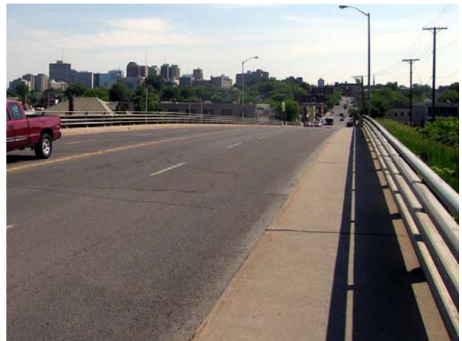
Vue vers l’est, depuis le pont Somerset, avant les travaux de reconception.
