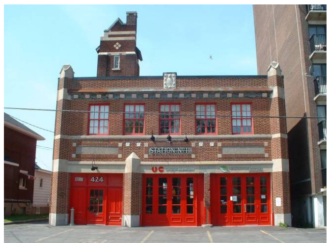
La caserne de pompiers Parkdale rénovée, édifice du patrimoine municipal, abrite une école de cuisine et une clinique de massothérapie.
