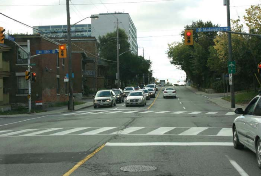
Exemple d'un passage pour piétons à une intersection de l'avenue Bronson doté de marques accentuées. Ces marques augmentent la visibilité du passage pour piétons pour les conducteurs. (McCormick Rankin Corporation)
