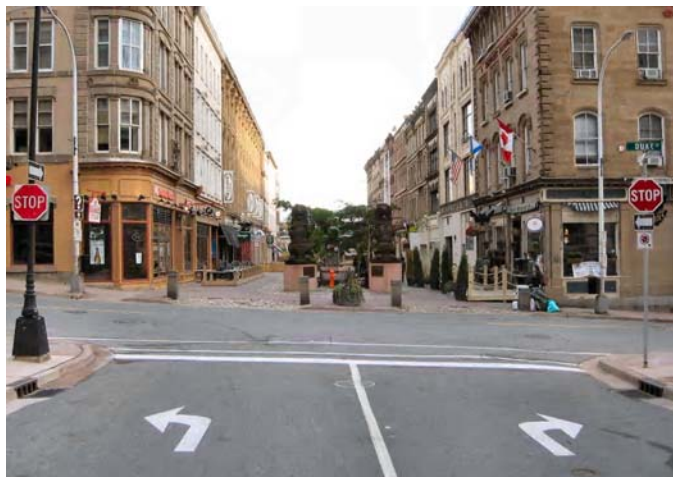
Dans ce cas, une branche de l'intersection a été convertie en espace réservé aux piétons. (McCormick Rankin Corporation)
