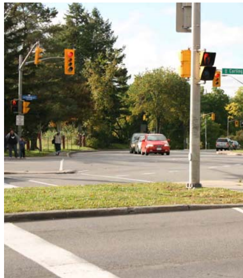
Les feux de circulation avec signaux pour piétons décrits ci-dessus et qu'on trouve sur l'avenue Carling ont été installés sur l'îlot central du côté éloigné de l'intersection pour en améliorer la visibilité. (McCormick Rankin Corporation)
