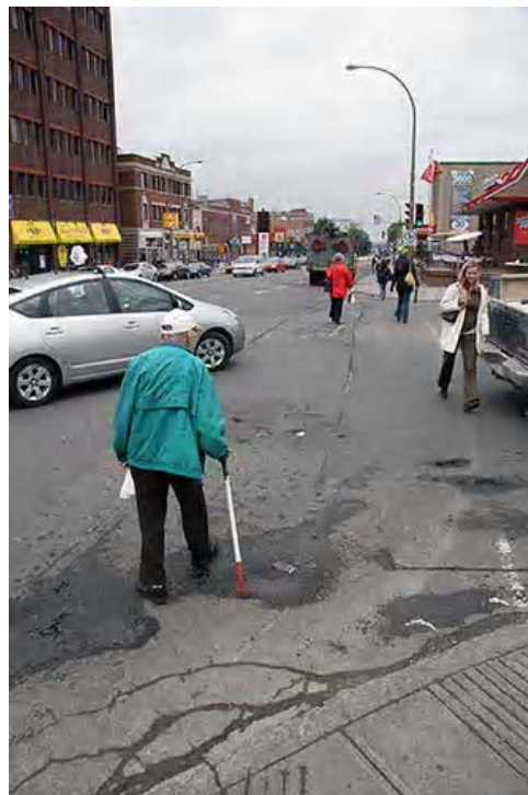
Sur la photo ci-dessus, l'état de détérioration des marques sur la chaussée les rend difficiles à repérer pour les automobilistes. ( www.pedbikeimages.org/ Dan Burden)
