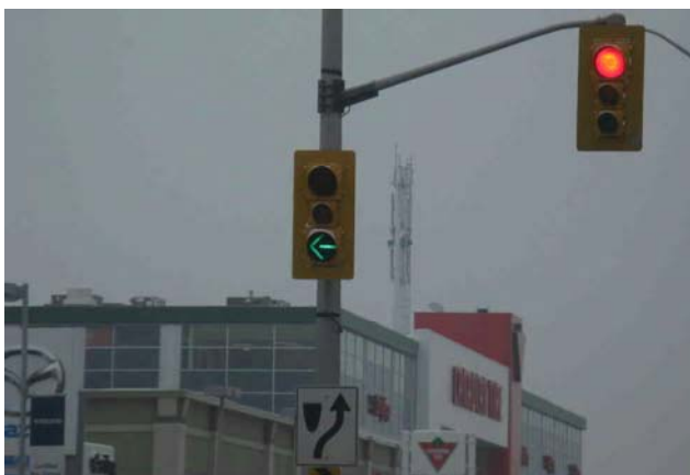
Une phase spéciale de tourneàgauche permet à la majorité des véhicules effectuant un virage à gauche de libérer l'intersection avant que les piétons ne s'engagent dans l'intersection, et réduit la possibilité de conflits. (Ville d'Ot-
