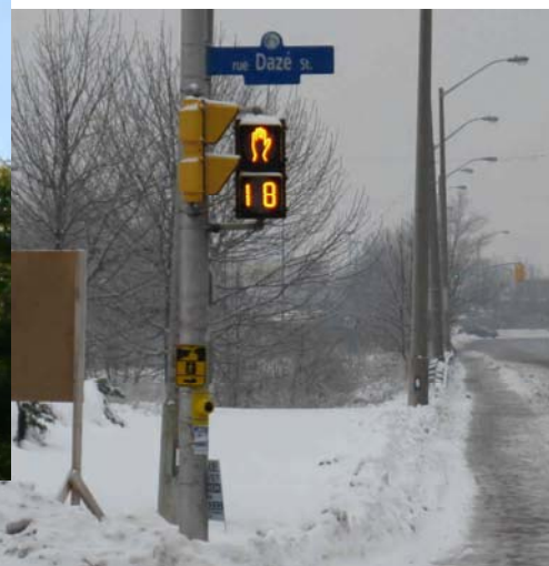
Exemple d'un feu de signalisation avec décompte numérique. (City of Ottawa)
