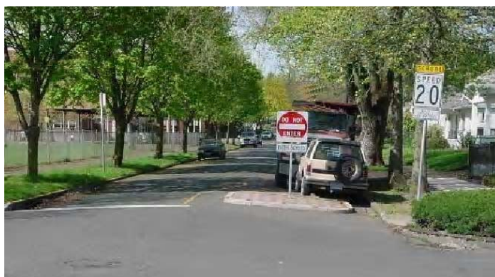
Exemple de la fermeture partielle d'une intersection qui empêche les véhicules de s'engager dans la rue. Soulignons que la signalisation illustrée ici n'est pas conforme aux pratiques de la Ville d'Ottawa pour ce type de mesure. ( www.pedbikeimages.org/ Dan
