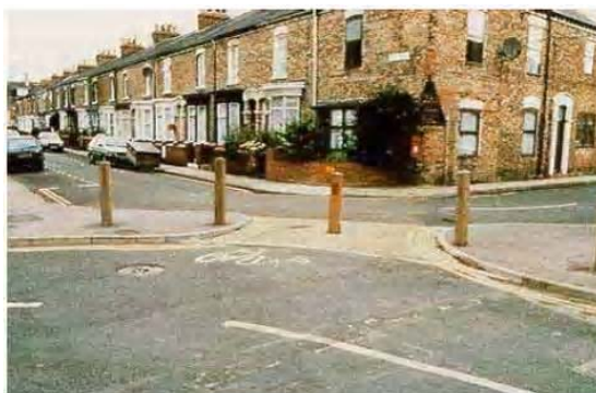
La photo ci-dessus montre une barrière de déviation en diagonale dont les bornes amovibles permettent le passage des véhicules d'urgence. L'illustration à droite présente les quatre principaux types de barrières de déviation. (FHWA University Course on Bicycle and Pedestrian Transportation)
