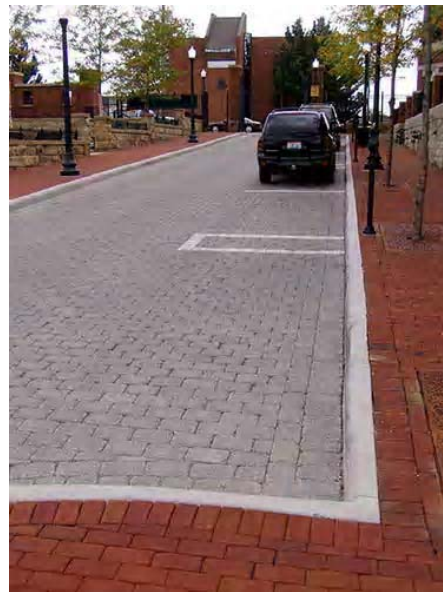
Un revêtement de sol particulier a été appliqué sur une rue paisible de Columbus en Ohio ( www.pedbikeimages.org/ Dan Burden).
