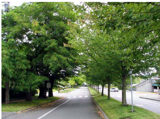
Le rétrécissement des voies peut constituer un moyen efficace pour diminuer la vitesse des véhicules et améliorer l'attention des automobilistes. ( www.pedbikeimages.org/ Dan Burden)
