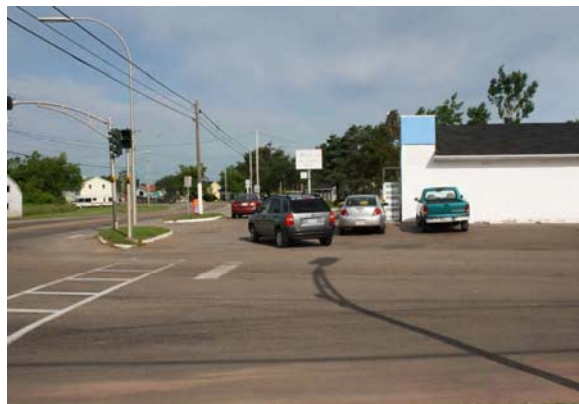
Exemple de mauvaise gestion d'accès à proximité d'un passage pour piétons. Dans ce cas, le passage pour piétons n'est pas doté d'un refuge et les véhicules circulent à vitesse élevée à l'entrée et à la sortie de l'aire de stationnement. (McCormick Rankin Corporation)
