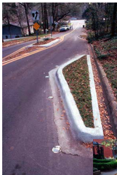
Les photos ci-dessus montrent des chicanes situées entre des intersections. Elles obligent les véhicules à se déplacer de façon latérale et, si elles sont bien conçues, elles inciteront les automobilistes à réduire leur vitesse. ( www.pedbikemages.com/ Dan Burden)
