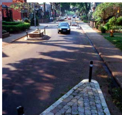
Les photos ci-dessus montrent des chicanes situées entre des intersections. Elles obligent les véhicules à se déplacer de façon latérale et, si elles sont bien conçues, elles inciteront les automobilistes à réduire leur vitesse. ( www.pedbikemages.com/ Dan Burden)
