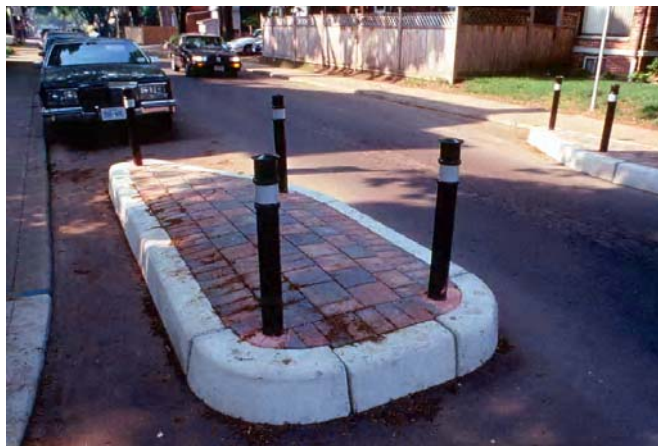
Exemple de rétrécissements de la chaussée qui rendent la voie de circulation plus étroite tout en permettant le stationnement sur rue. ( www.pedbikeimages.org/ Dan Burden)
