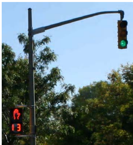
Un feu de signalisation avec décompte numérique à l'intersection de la promenade Vanier et de la rue Donald. (McCormick Rankin Corporation)
