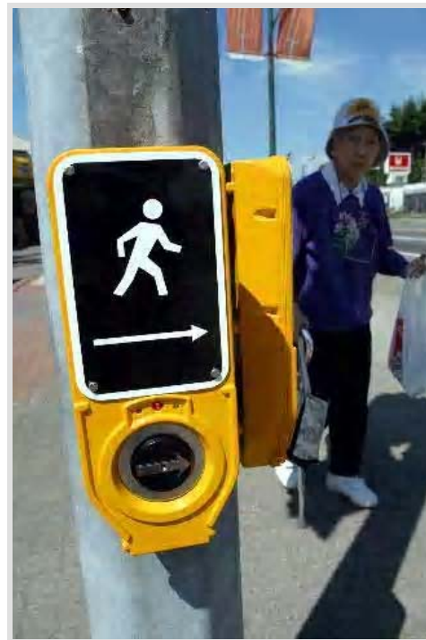
Le bouton poussoir SSP ci-dessus n'est qu'un exemple des nombreux types de boutons qui émettent un signal sonore facilitant leur repérage par les piétons ayant une déficience visuelle. Au moyen d'indications sonores et vibratiles, ces boutons signalent l'apparition du « piéton » dans le sens indiqué par la flèche de direction tactile. ( www.pedbikeimages.org/ Dan
